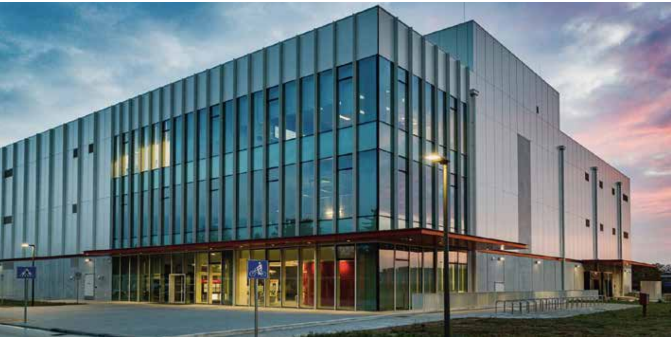
DATA CENTER EQUINIX - MILANO
